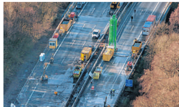
Blick aus der Vogelperspektive auf die Baustelle zwischen Dortmund-Süd und Kreuz Dortmund/Witten. Foto: Hans Blosssey
